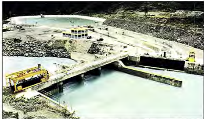
Vista general obras de Cabecera: río San Gabán, bocatoma, desarenadores, embalse de regulación horaria. General view of the Head Works : San Gabán's river, water inlet, sand traps, hourly regulating reservoir.
