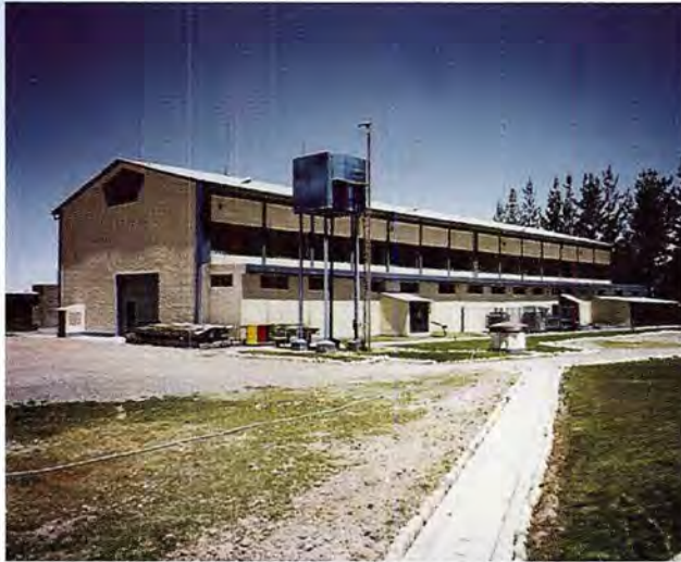
Vista exterior de la Central Térmica de Taparachi. External view at the Taparachi Thermal Power Station.
