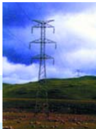
Líneas de transmisión Macusani-Carabaya Transmission lines Macusani-Carabaya
