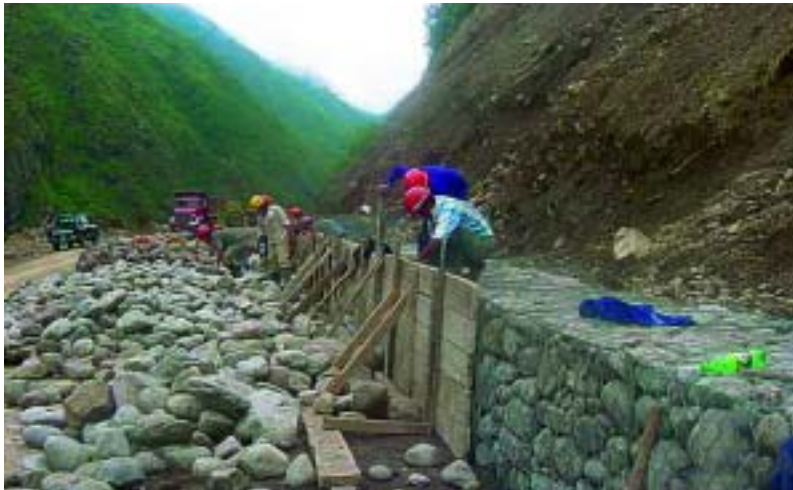
Construcción de muro de gaviones para el sostenimiento de taludes en la zona de Tunquini. Construction of gabion wall for the support of talus in the Tunquini zone
