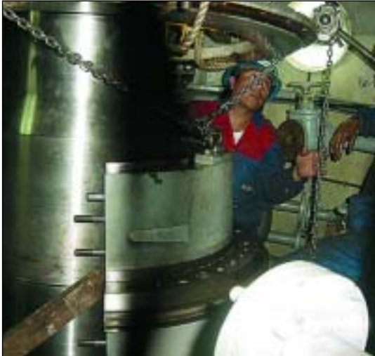
Inspección y modificación del Cojinete Guía Turbina Inspection and modification of the Guide Bearing Turbine
