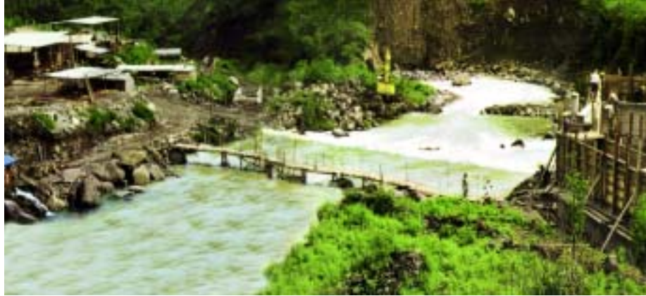
Antiguo Puente de acceso a zonas de obras de cabecera, trabajos para bases de nuevo puente (1995) Old access bridge to the zones of head works, works for foundations of new bridge (1995)
