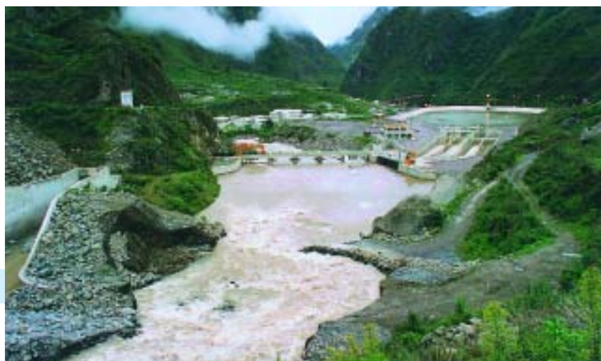
Obras de Cabecera de la C.H.S.G. II y río San Gabán Head Works San Gabán II Hydroelectric Power Plant and San Gabán River
