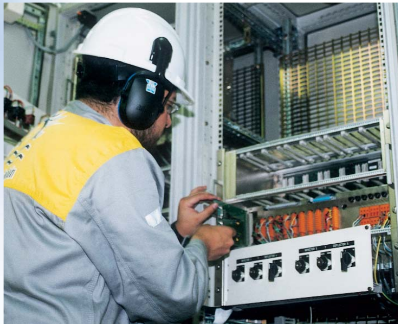
Labores de mantenimiento electrónico en casa de máquinas / Maintenance work on Power Station.
