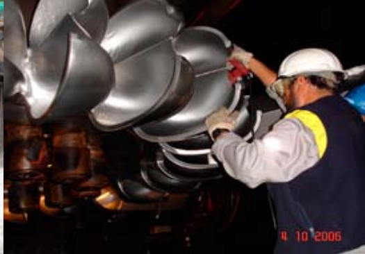
Mantenimiento turbina pelton Pelton Turbine maintenance
