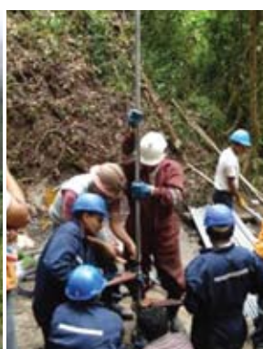
Trabajos de perforación diamantina C.H. San Gabán III Diamond drilling Works , San Gabán III Hydroelectric Power Plants
