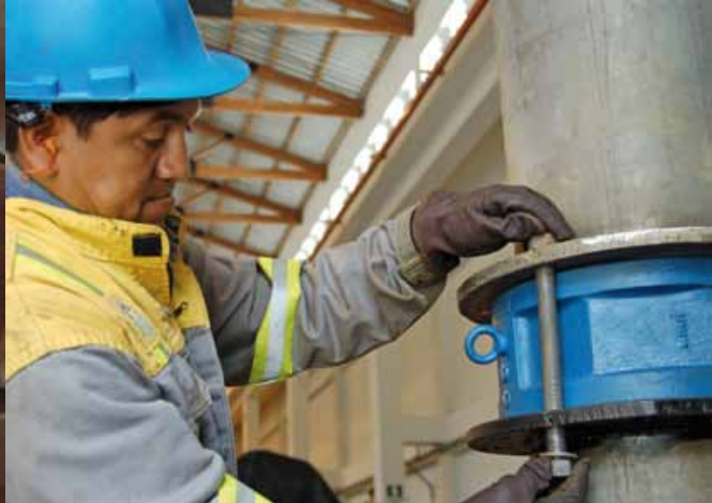
Actividades de mantenimiento / Maintenance activities
