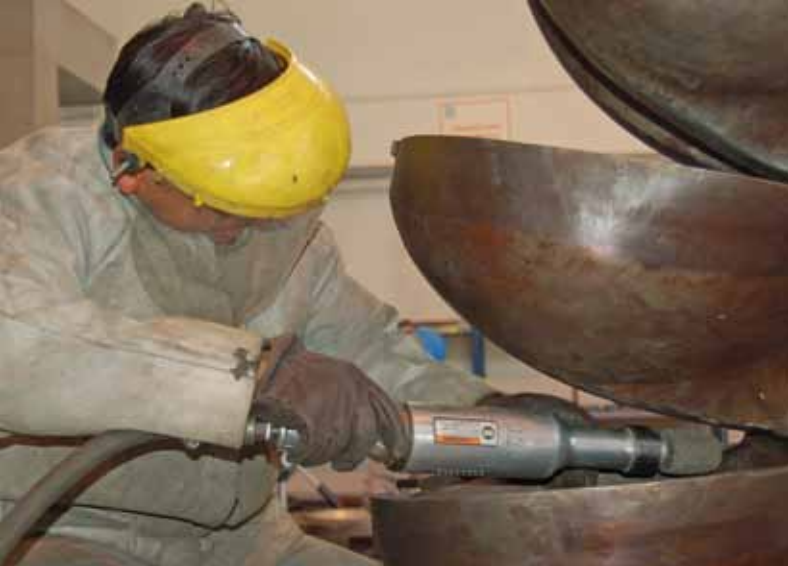
Mantenimiento turbina Pélton / Pelton turbine maintenance
