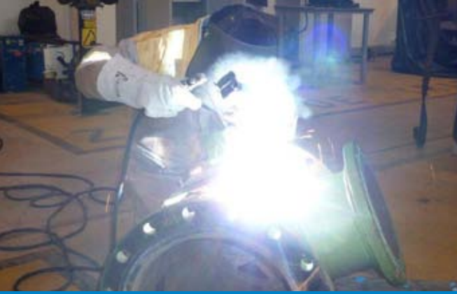
Actividades de mantenimiento en el taller mecánico
