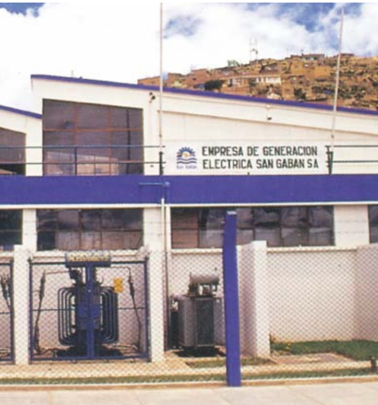
Central térmica de Bellavista - Puno
