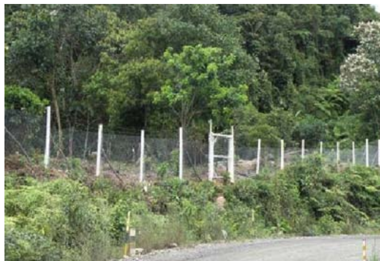
Fig. 83: Cerco metálico colocado por el Consorcio Intersur hacia fines del 2008 (Foto: : Cortesía Consorcio Intersur)
