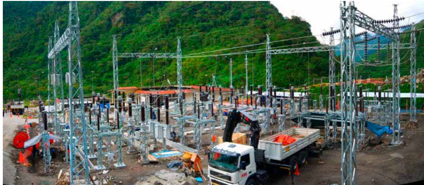
Construcción del Nuevo Patio de Llaves en la Subestación San Gabán II. / New switchyard at San Gabán II Substation.
