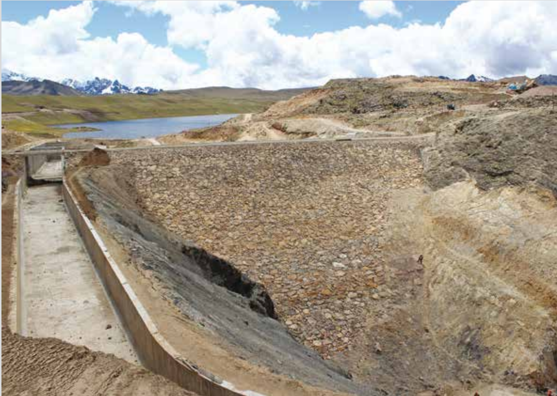
Presa Pumamayo (32 MMC) Talud aguas abajo / Pumamayo dam [32 MMC] downstream slope
