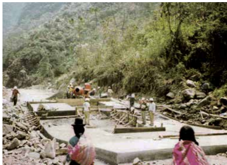
Construcción de badenes para canalizar las quebradas
