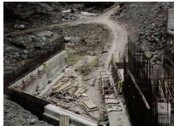
Estructura de la Toma del desripador (Obras Cabecera)
