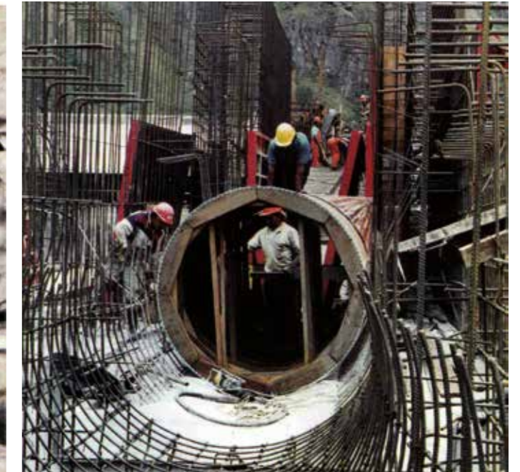
Obras de Cabecera: Construcción del Conducto Cubierto
