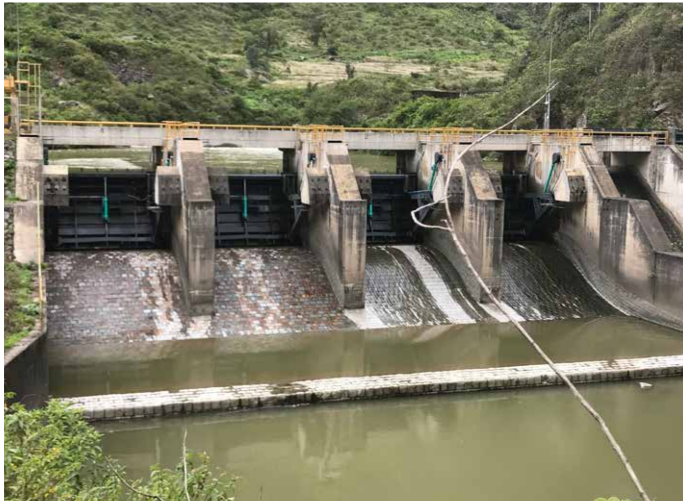
Mantenimiento de la presa derivadora
