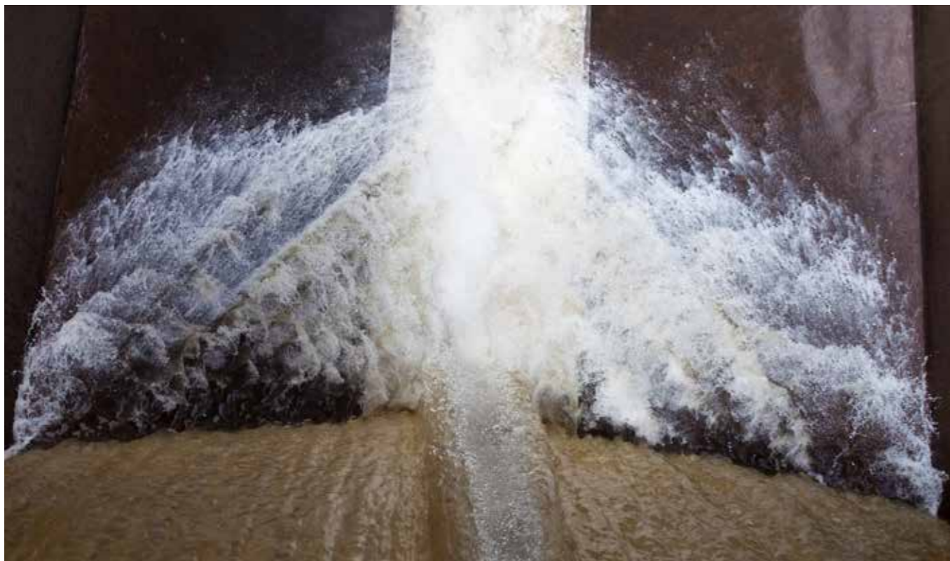
Rebose de aguas del río San Gabán sobre compuerta radial, Chuani
