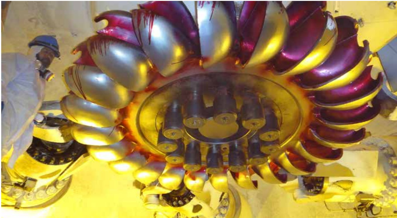
Inspección de Rodete del generador en Casa de Máquinas
