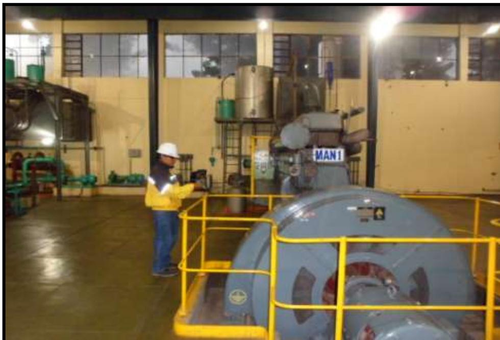
**Fotografía 2: Monitoreo de Radiaciones electromagnéticas**
